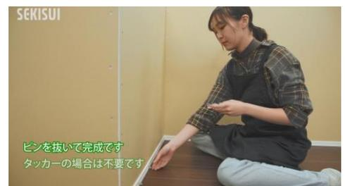
(図10) 押しピンの取外し
